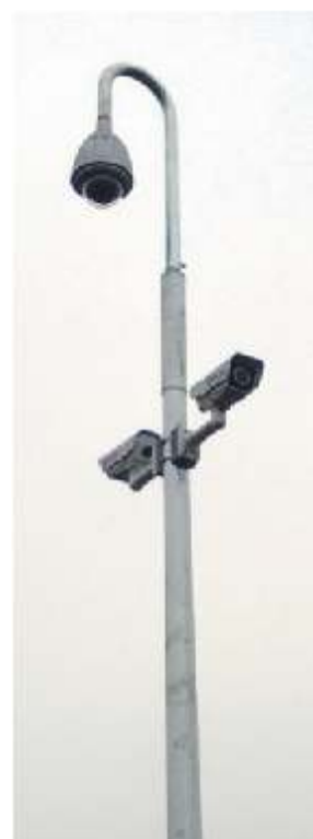
Uchwyt kamery obrotowej SNB-T-48 na słupie
