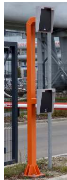
Słupek czytnika PCR-2300x2 z czytnikami dalekiego zasięgu
