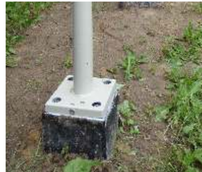
Fundament F1 ze słupkiem
