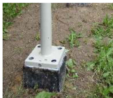
Fundament F1 ze słupkiem
