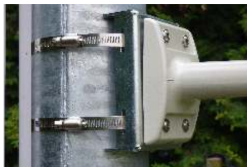
Adapter PMA-S-50-10 zainstalowany na słupie obejmami zaciskowymi
