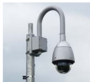
Adapter słupowy PMA-L-20 z uchwytem SBN-BOX-20 zainstalowany na słupie
