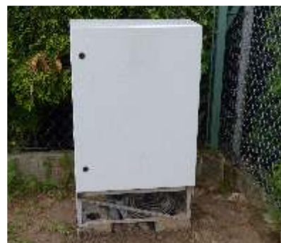
Fundamenty F1 z szafą
